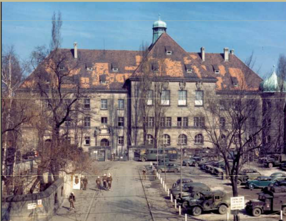
Schwurgerichts- gebäude zur Zeit der Prozesse
